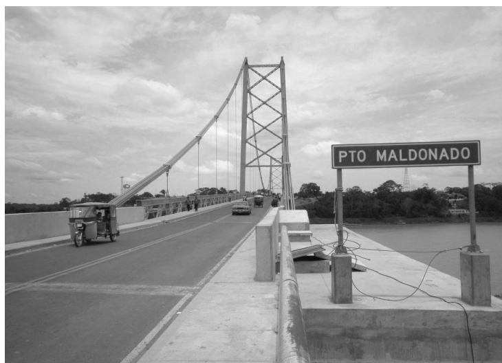
Figuras 7 – Ponte Intercontinental de Puerto Maldonado/Peru.
