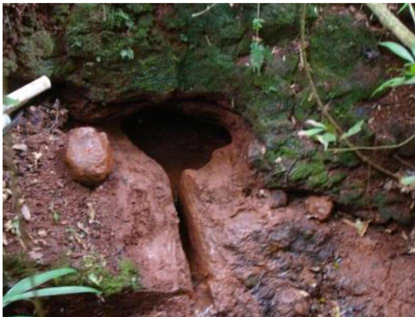
Figura 4 – Nascente sendo preparada com a limpeza interna e externa e escoamento da água para se instalar as tubulações
